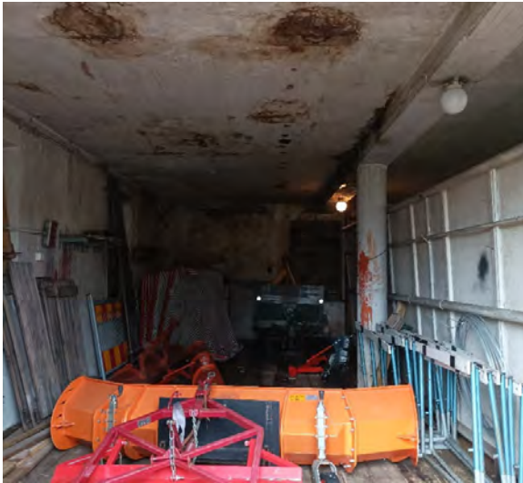
Kuvat 27 ja 28. Tervajoen rannassa oleva tiilirakennus. Rakennuksen sisäkatoissa on laajat vauriot ja katon suojana ollut peite on repeillyt.
