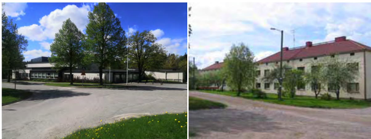
Kuvat 24 ja 25. Tervajoen rannalla oleva Seuratalo sekä Sähkötalot Pikkuniityntien varrelta.
