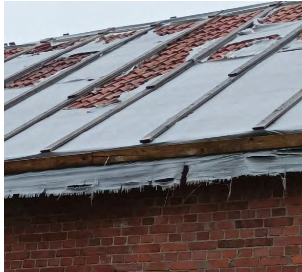
Kuvat 27 ja 28. Tervajoen rannassa oleva tiilirakennus. Rakennuksen sisäkatoissa on laajat vauriot ja katon suojana ollut peite on repeillyt.
