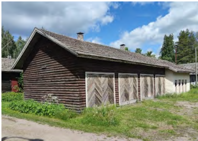
Kuva 28 Varastorakennuksen puujulkisivua Porttilantien varrella.
