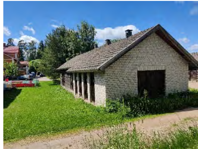
Kuva 29 Varastorakennuksen tiilipäättyä Paperintekijäntien varrella.
