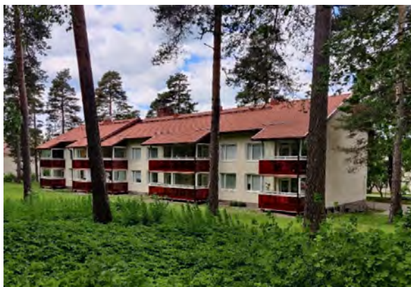
Kuva 7 Pikkuniityntien kaksikerroksinen asuinkerrostalo, johon on vuonna 2009 lisätty punaiset parvekelasit parvekkeiden suurennuksen yhteydessä.
