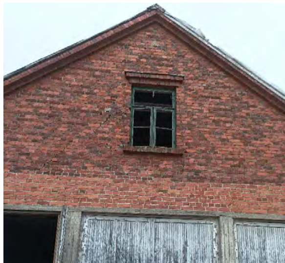
Kuvat 29 ja 30. Rakennuksen tiilirakenteet ovat osin romahtaneet ja saumat halkeilleet. Ikkunalasit ovat rikkoutuneet ja olleet pitkään avoimina.
