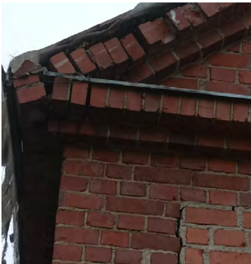
Kuvat 29 ja 30. Rakennuksen tiilirakenteet ovat osin romahtaneet ja saumat halkeilleet. Ikkunalasit ovat rikkoutuneet ja olleet pitkään avoimina.
