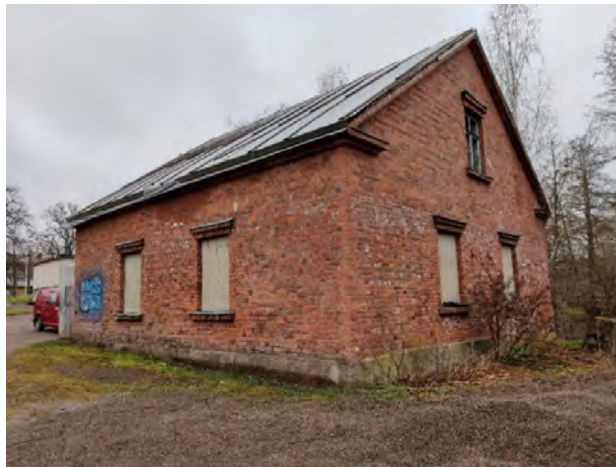
Kuva 36 Nykyinen tiilirakennus kuvattuna etelästä päin. Alkuperäinen tiilikatto on peitetty muovipressulla.
