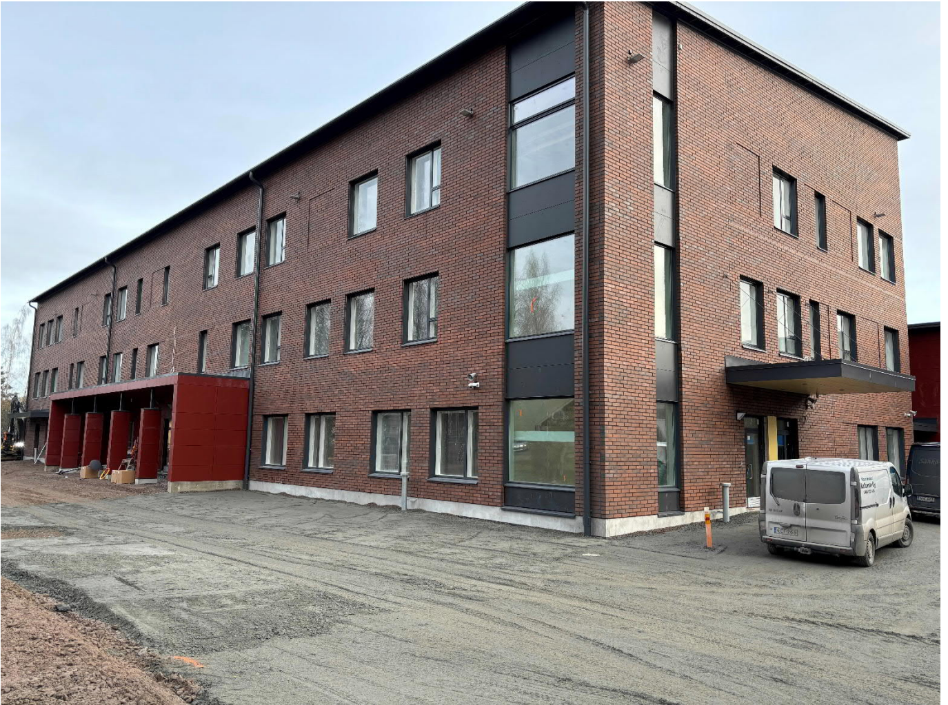
Julkisivu pääsisäänkäynnin puolelta.
