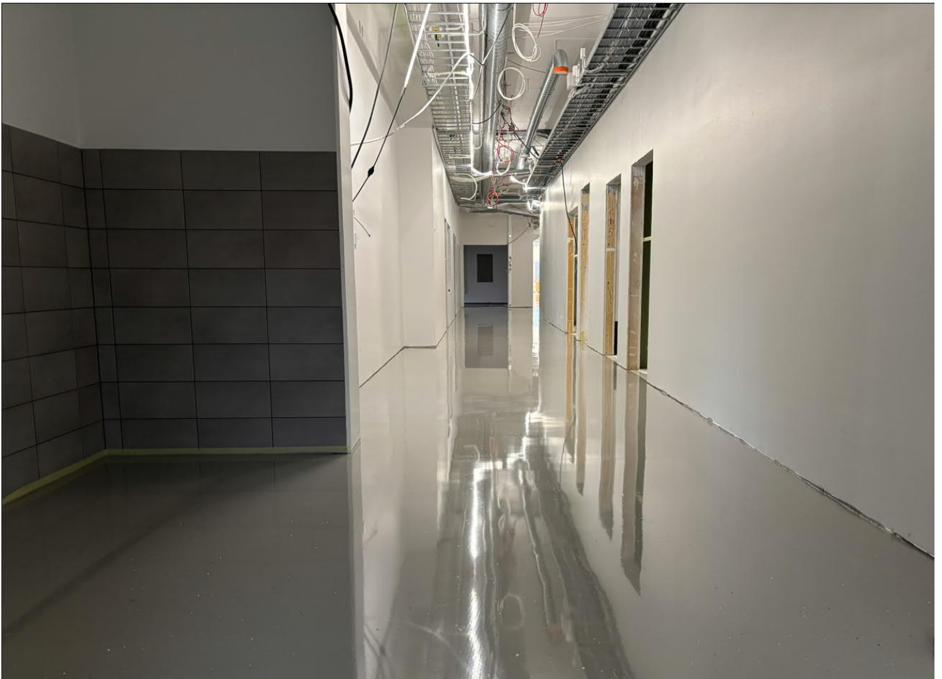
Kuvassa 2. kerroksen käytävän lattiaa valmiina
