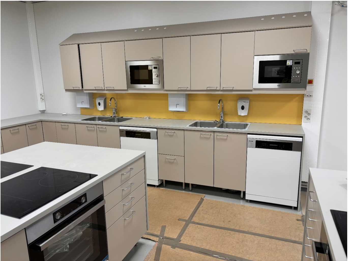
Kuvassa kotitalousluokan kalusteita ja varusteita asennettuna
