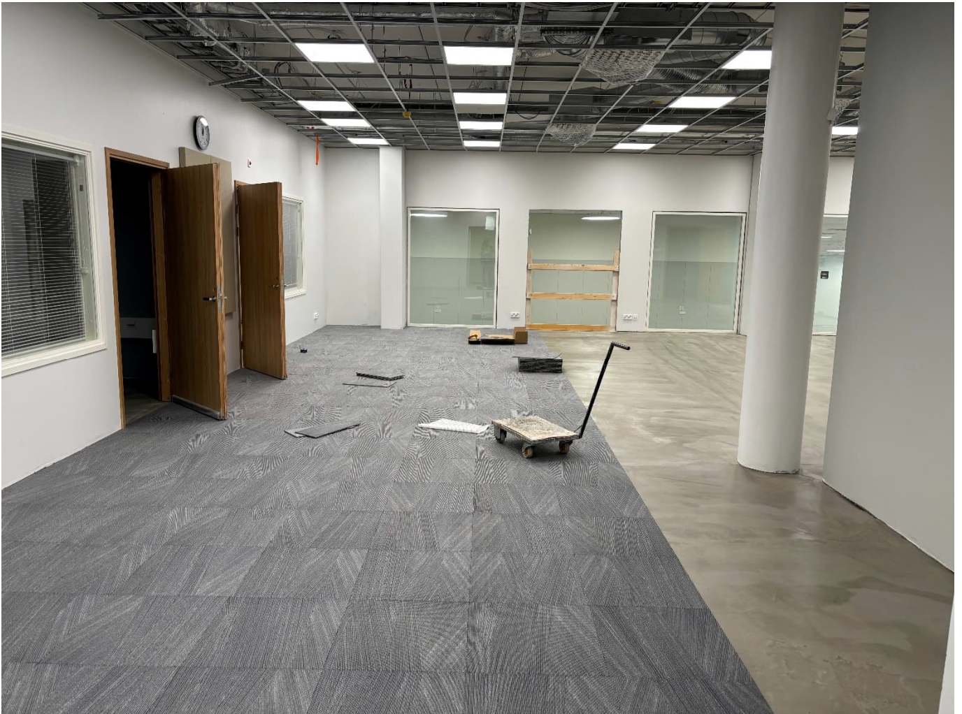
Kuvassa opettajanhuoneen tekstiilimattolattian asennusta
