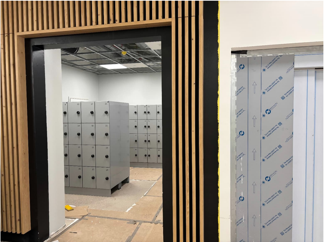
Kuvassa aulan lokerikkojen keskeneräinen asennus ja rimaseiniä
